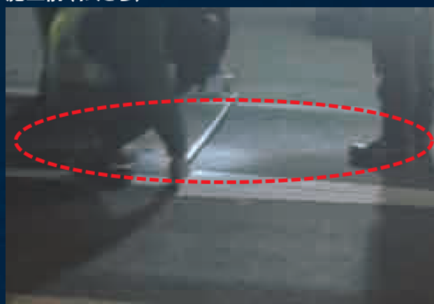
施工前(わだち)
